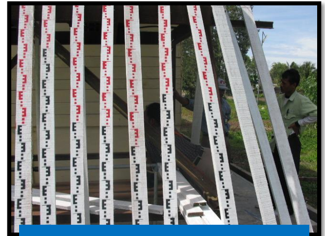
Alat Ukur Peilscaal dipasang di kanal maindrain dan outlet
